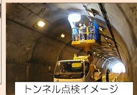
トンネル点検イメージ
