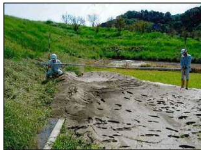
洪水時の堤防等の漏水
