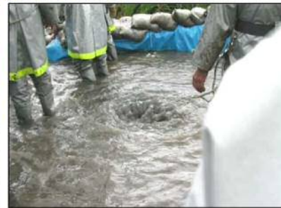
洪水時の堤防等の漏水
