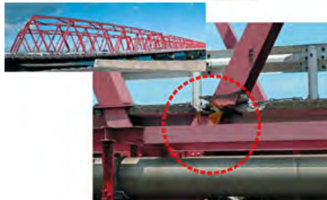
橋桁の破断
