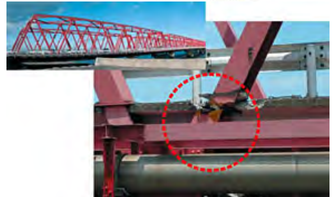
橋桁の破断
