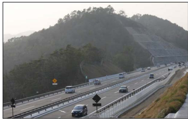
▲尾道自動車道全線開通後の甲奴C付近から吉舎IC方向を望む(左図中に位置を表示)
