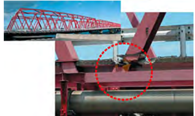
橋桁の破断
