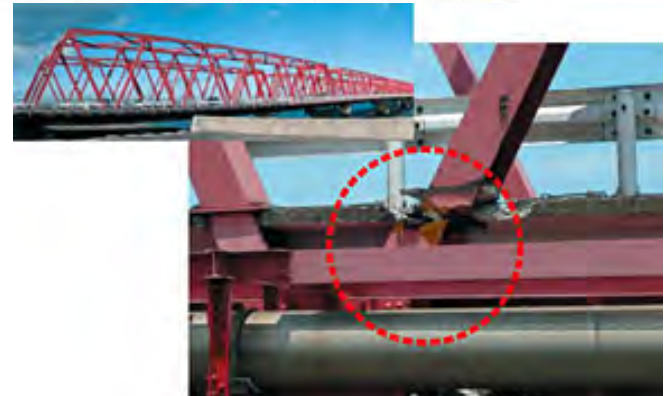
橋桁の破断
