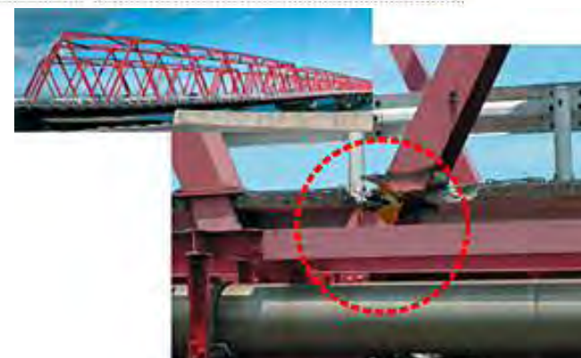
橋桁の破断
