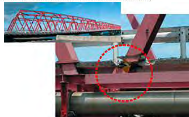
橋桁の破断
