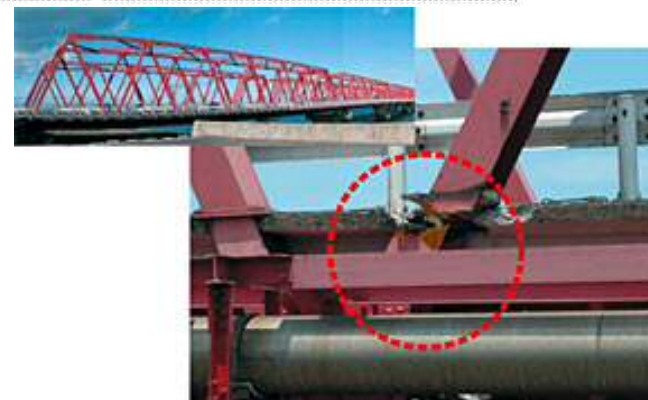
橋桁の破断
