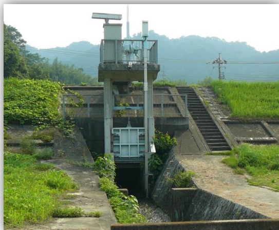
芦田川の排水樋門
