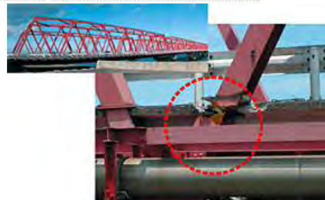
橋桁の破断
