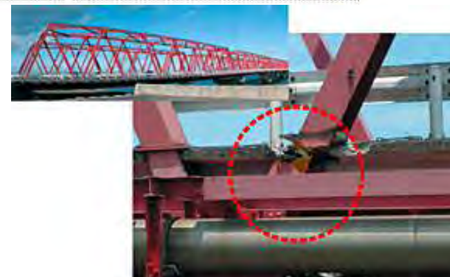
橋桁の破断
