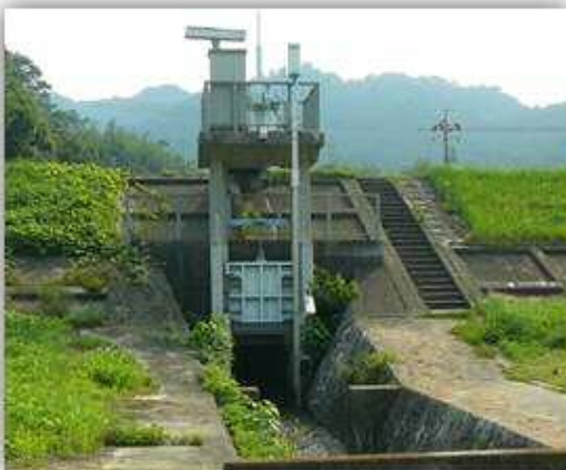
芦田川の排水樋門
