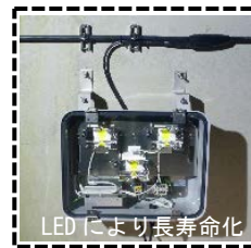
取替後のトンネル照明設備
