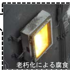
現状のトンネル照明設備
