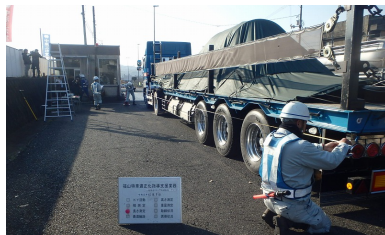
車両寸法計測状況
