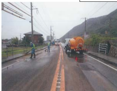
土砂撤去〔広島県三原市〕
