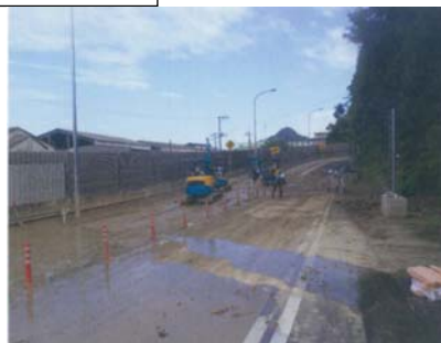
路面清掃〔広島県三原市〕
