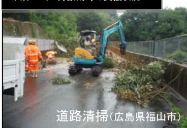
平成30年7月豪雨時の支援状況
