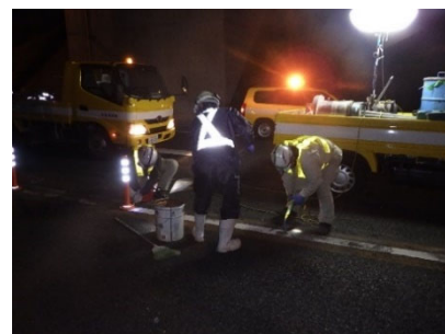
安全施設の更新状況
