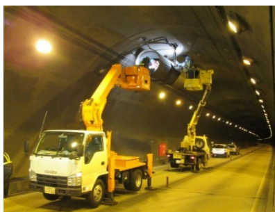
ジェットファン点検状況
