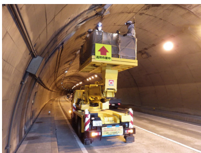
トンネル照明更新作業状況
