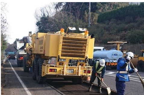
舗装版の破碎
