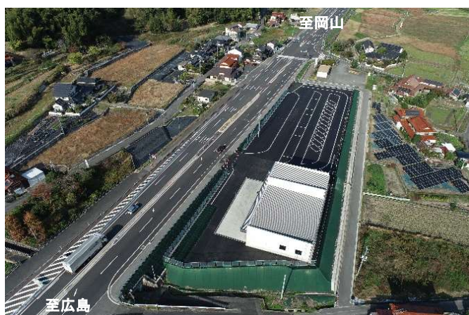
完成した除雪基地(R6. 11時点)
