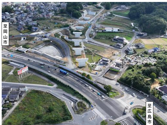
あかさか はやと 現状（赤坂バイパス早戸ランプ交差点付近）
