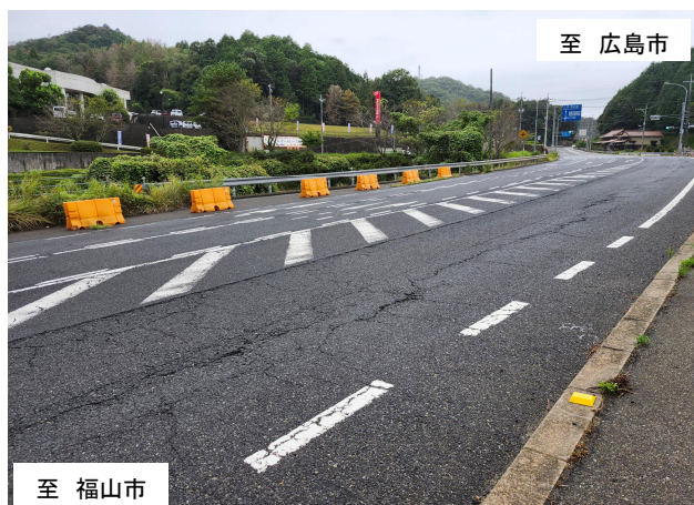
現状の舗装状況
