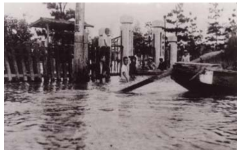
南小学校前の浸水状況
