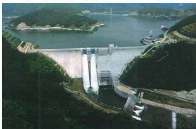
写真 1-2-4 八田原ダム (平成 10 年 3 月完成)
