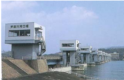
写真 1-2-3 芦田川河口堰 (昭和 56 年 6 月完成)
