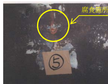
写真 2-3-5 放流管の劣化状況
