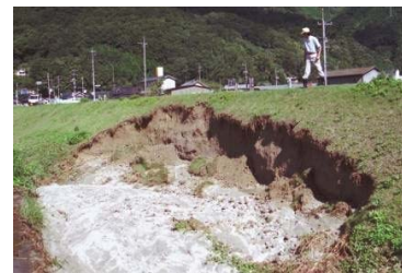
写真 2-3-10 洪水による堤防の損傷
