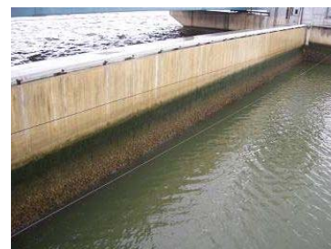
写真 2-3-6 主ゲートの劣化状況
