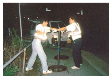
写真 2-2-2 平成 6 年の渇水状況 (夜間断水作業の状況)
