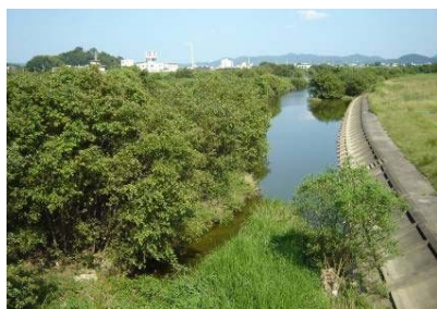
写真 2-3-3 河道内樹木の繁茂
