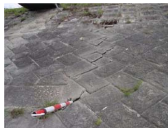
写真 2-3-2 老朽化による護岸のクラック
