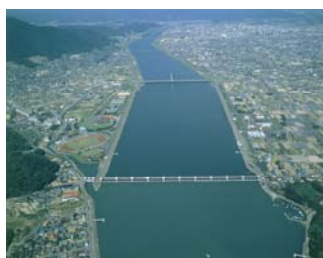
写真 2-2-24 芦田川河口堰と湛水区間
