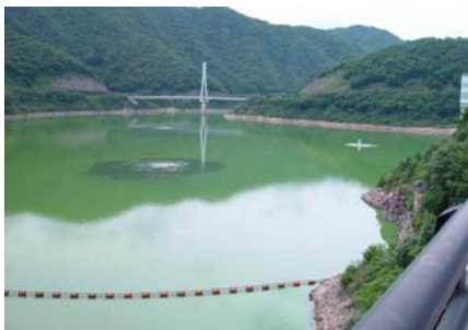
写真 2-2-35 アオコの発生状況(八田原ダム)
