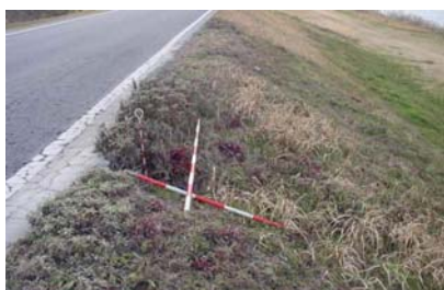
写真 2-3-1 堤防の陥没
