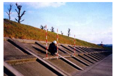
写真 5-2-5 洪水痕跡調査
