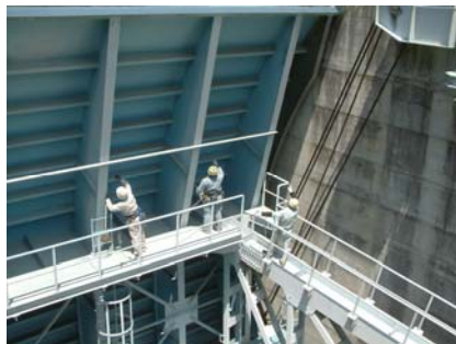
写真 5-2-16 クレストゲートの点検状況
