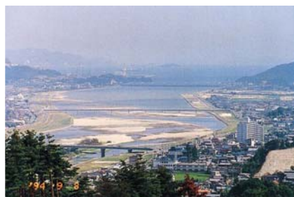
写真 5-2-19 芦田川河口堰湛水域の枯渇状況 (平成 6 年渇水)
