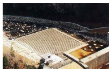
写真 5-1-11 礫間接触酸化施設
