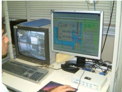
写真 5-2-29 排・取水門の遠隔操作状況
