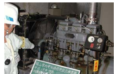
写真 5-2-3 排水ポンプ場の点検状況
