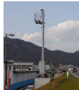
写真 5-2-11 CCTV の設置状況
