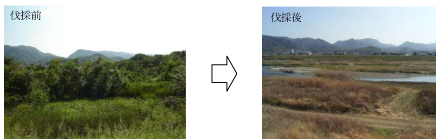
図 5-2-13 河道内樹木の伐採状況 (18k200 付近)
