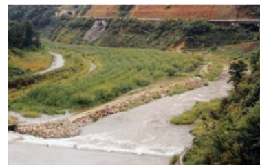
写真 5-1-9 植生浄化施設
