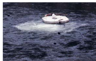
写真 5-1-10 躍層低下循環施設
