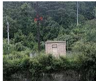
写真 5-2-17 八田原ダム放流警報設備
