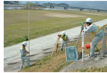
写真 5-2-4 縦横断面測量
