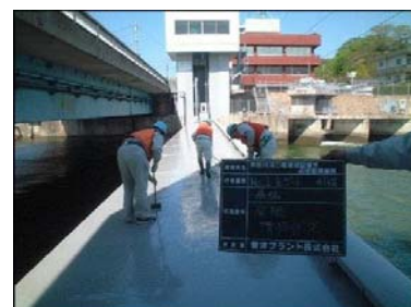
写真 5-2-18 ゲート管理・点検
