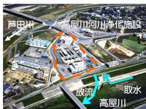
写真 5-1-8 高屋川河川浄化施設
