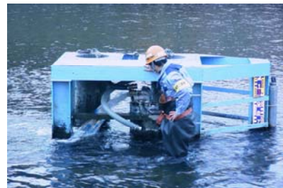
写真 5-2-24 水質観測装置の点検状況
