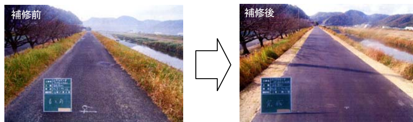
写真 5-2-9 堤防天端（上面）の補修状況
