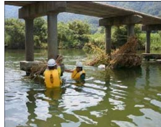
写真 5-2-15 潜水橋に付着したゴミの除去
