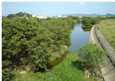
写真 2-3-3 河道内樹木の繁茂
