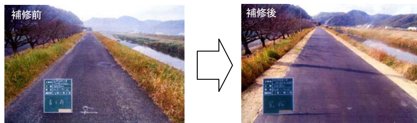
写真 5-2-9 堤防天端（上面）の補修状況
