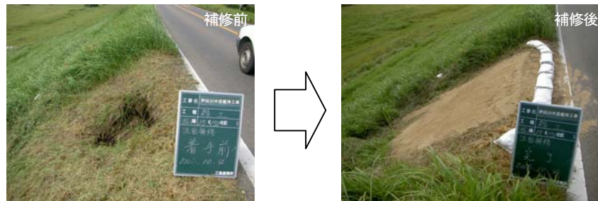
写真 5-2-8 堤防の補修状況
