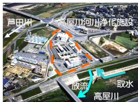
写真 5-1-8 高屋川河川浄化施設
