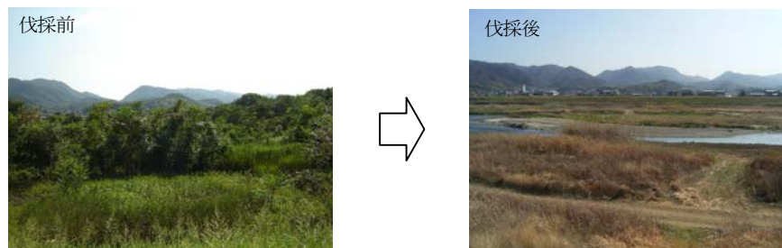
図 5-2-13 河道内樹木の伐採状況（18k200 付近）
