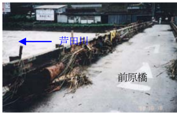
写真 2-1-1 平成 10 年 10 月洪水の状況
