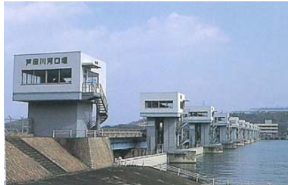
写真 1-2-3 芦田川河口堰（昭和 56 年 6 月完成）
