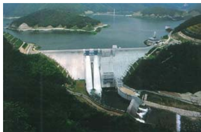
写真 1-2-4 八田原ダム（平成 10 年 3 月完成）
