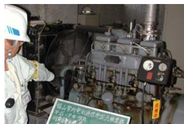
写真 5-2-3 排水ポンプ場の点検状況
