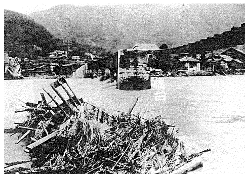
府中市父石町の浸水状況
