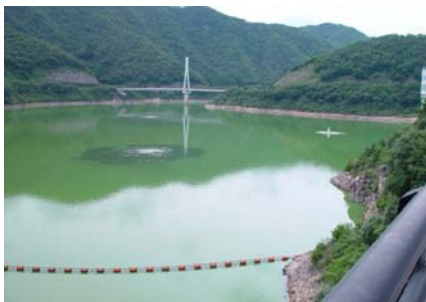
写真 2-2-35 アオコの発生状況(八田原ダム)
