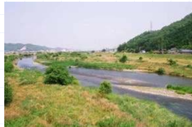
樹木などの繁茂(中須大橋付近)
