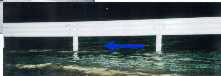
前原橋付近の越水状況（府中市）
