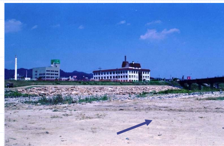
府中大橋下流の枯渇状況(府中市)
