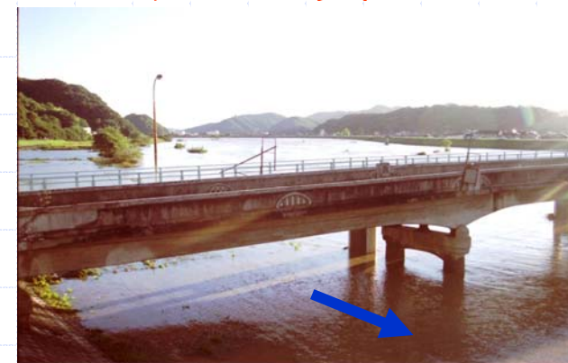
中津原の出水状況（福山市）
