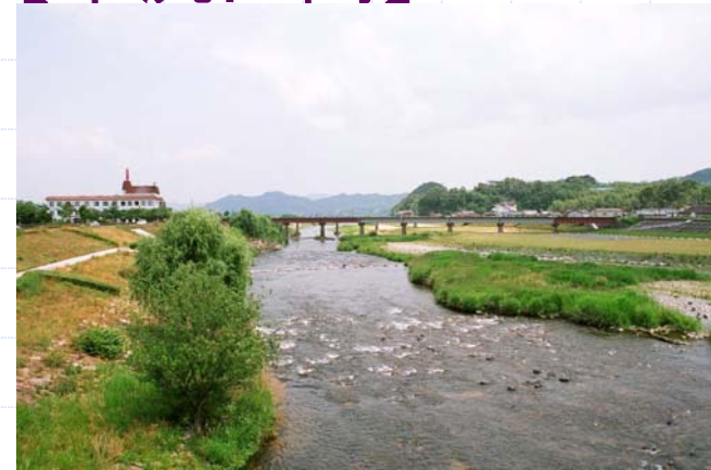
早瀬の連続する河道(府中新橋付近)
