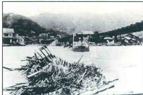
昭和20年9月洪水（府中市付近）
