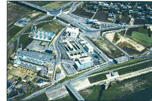
高屋川河川浄化施設
