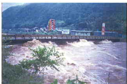
写真3 目崎箇所(府中市目崎町) 〈昭和60年6月洪水〉
