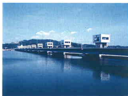
写真6 芦田川河口堰
