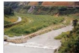
植生浄化施設
