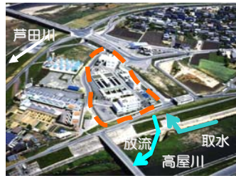
高屋川河川浄化施設
