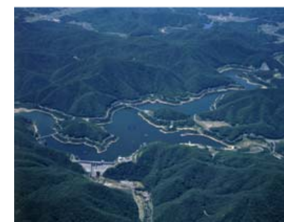
八田原ダム (H10.3完成)
