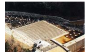
礫間接触酸化施設
