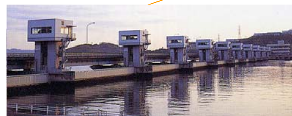
芦田川河口堰と河口大橋
