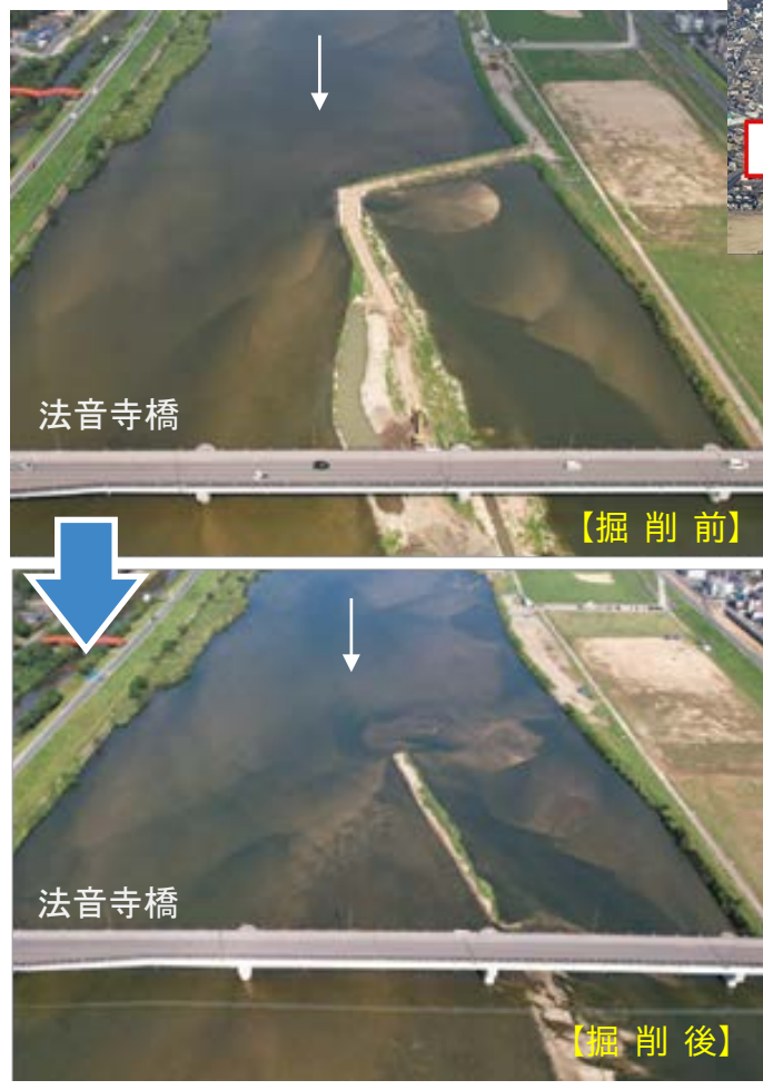
法音寺橋付近 施工状況
