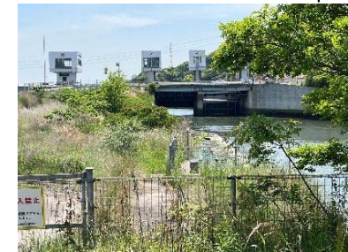
右岸魚道(下流側)
