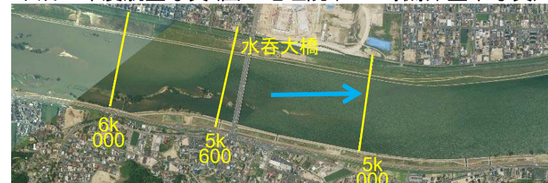
平成30年度航空写真(国土地理院(H30.7撮影)空中写真)
