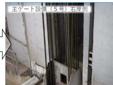
令和2年10月27日 復旧状況
