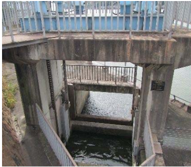
左岸魚道(下流側)
