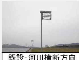
既設: 河川横断方向 堤防側
