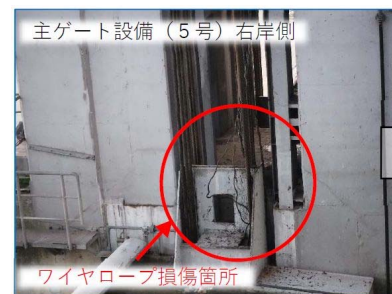
令和2年7月26日 ワイヤーロープ損傷発生状況
