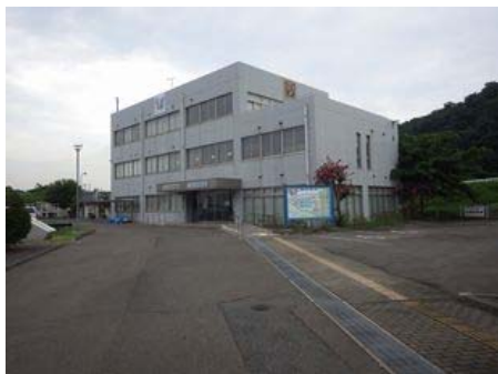
芦田川見る視る館
