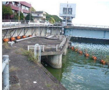
左岸魚道(上流側)
