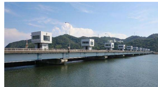
芦田川河口堰全景
