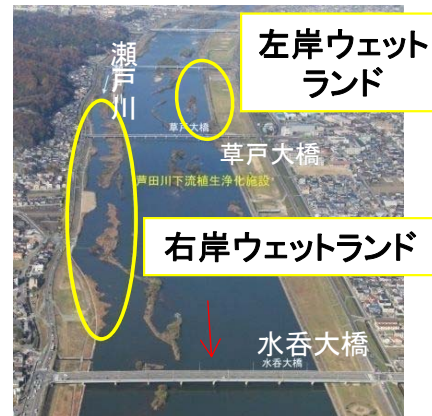
芦田川下流植生浄化施設
