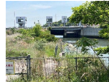
右岸魚道(下流側)
