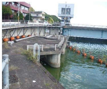
左岸魚道(上流側)
