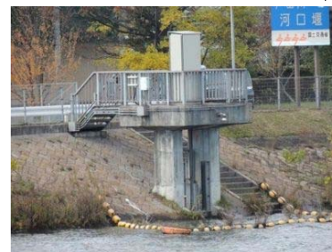
右岸魚道ゲート
