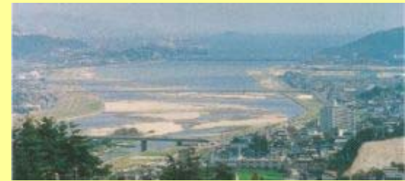
芦田川河口堰の枯渇状況
