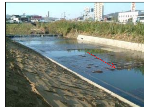
瀬戸川河川浄化施設
