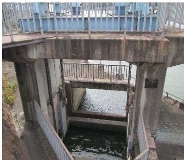
左岸魚道(下流側)
