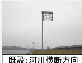
既設: 河川横断方向 堤防側
