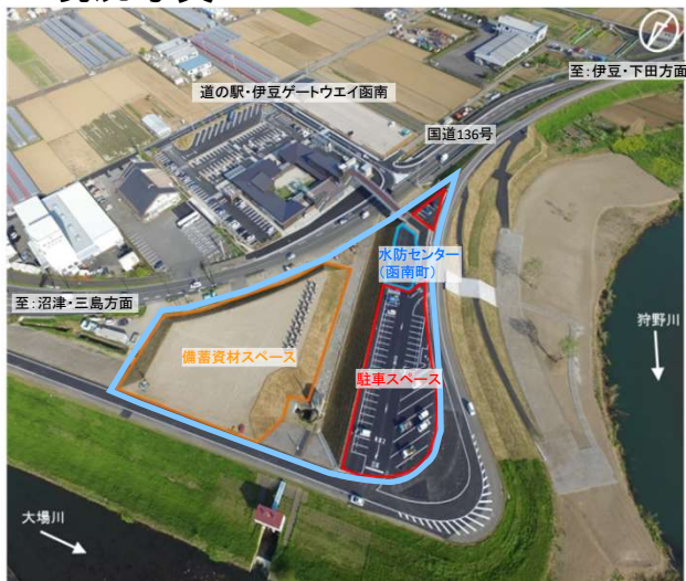
MIZBEステーションの現況
