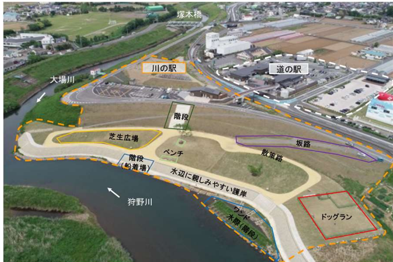
川の駅と道の駅からなる複合施設
