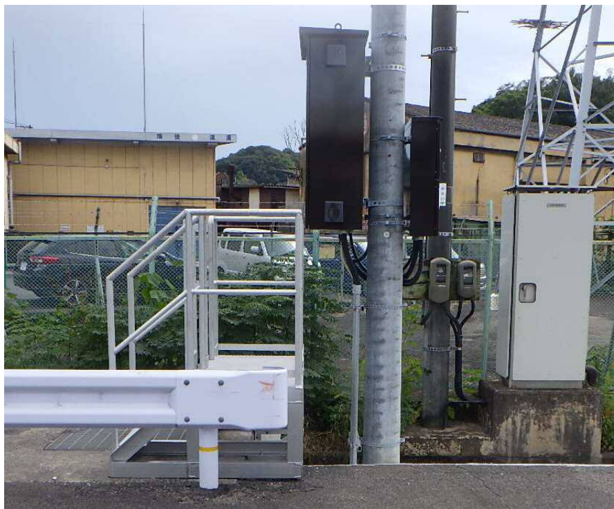
道路排水ポンプ更新（山手道路排水ポンプ）
