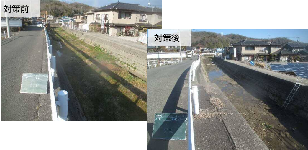
河道掘削（五入道川）
