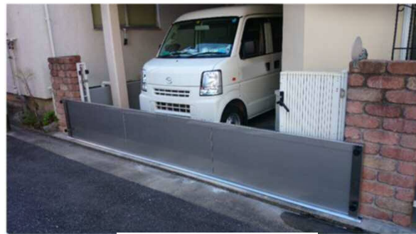
【止水板の設置例】
