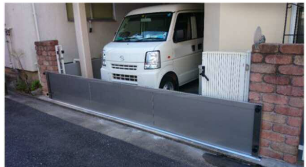
【止水板の設置例】
