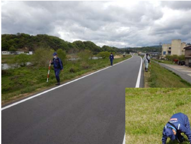
◀ 徒歩による点検で、堤防に異常が無いか確認
