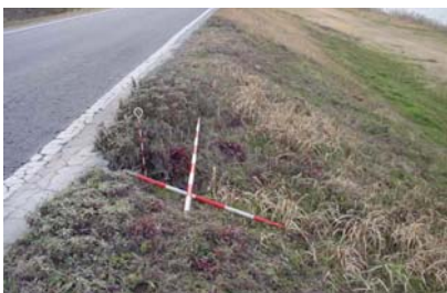
写真 2-3-1 堤防の陥没
