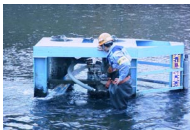
写真 5-2-24 水質観測装置の点検状況
