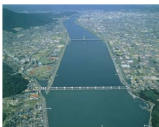
写真 2-2-24 芦田川河口堰と湛水区間
