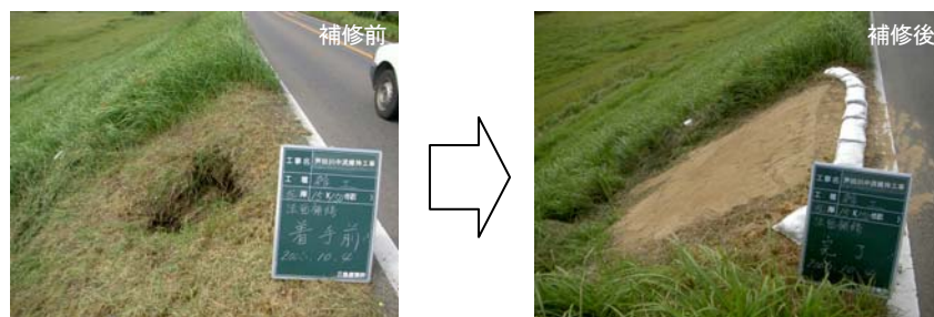
写真 5-2-8 堤防の補修状況
