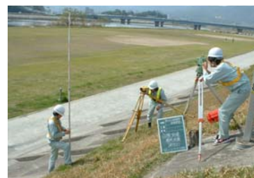
写真 5-2-4 縦横断測量
