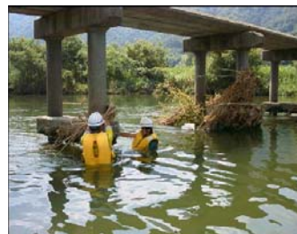
写真 5-2-15 潜水橋に付着したゴミの除去
