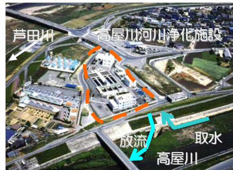
写真 5-1-8 高屋川河川浄化施設
