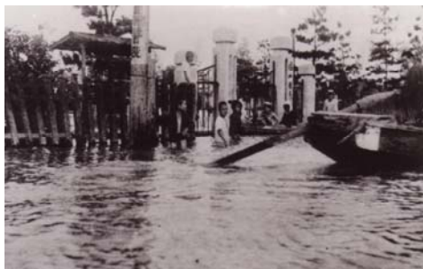
南小学校前の浸水状況
