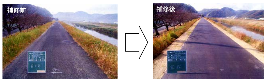
写真 5-2-9 堤防天端（上面）の補修状況
