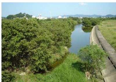
写真 2-3-3 河道内樹木の繁茂
