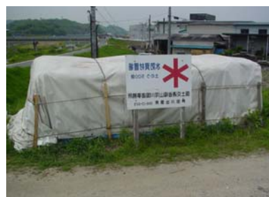
写真 5-2-34 緊急用資機材（土のう）の備蓄状況
