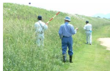
写真 5-2-2 堤防の点検状況
