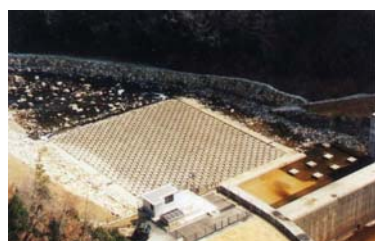
写真 5-1-11 礫間接触酸化施設
