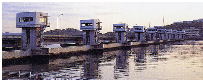
写真 2-2-25 芦田川河口堰と河口大橋
