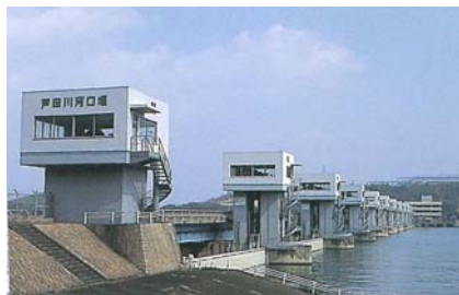
写真 1-2-3 芦田川河口堰（昭和 56 年 6 月完成）
