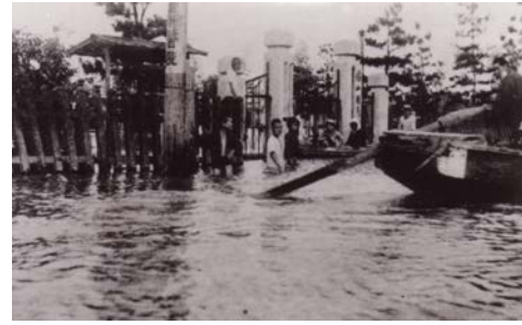
南小学校前の浸水状況
