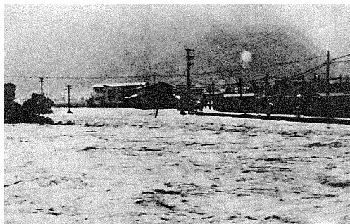
府中市府中町の浸水状況
