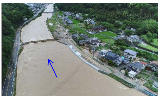
府中市父石町付近の浸水状況
