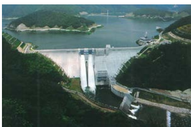
写真 1-2-4 八田原ダム (平成 10 年 3 月完成)
