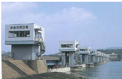
写真 1-2-3 芦田川河口堰 (昭和 56 年 6 月完成)
