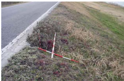
写真 2-3-1 堤防の陥没
