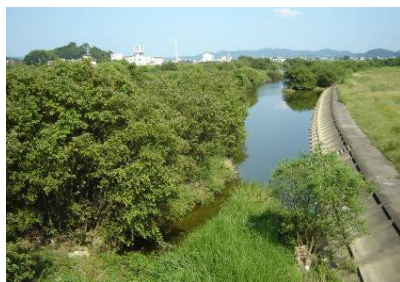
写真 2-3-3 河道内樹木の繁茂
