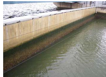
写真 2-3-6 主ゲートの劣化状況
