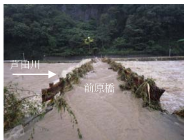
写真 2-1-1 平成 30 年 7 月豪雨の状況
