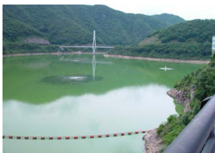
写真 2-2-36 アオコの発生状況（八田原ダム）
