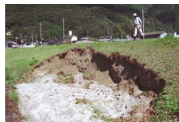
写真 2-3-8 洪水による堤防の損傷
