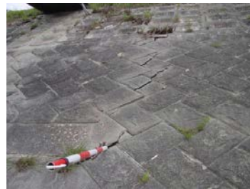
写真 2-3-2 老朽化による護岸のクラック
