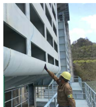
写真 2-3-5 ゲート扉体の点検状況
