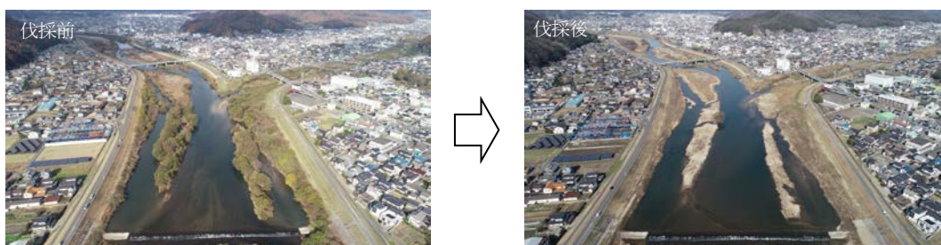
写真 5-2-13 河道内樹木の伐採状況 (22k 付近)
