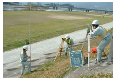
写真 5-2-4 縦横断面測量
