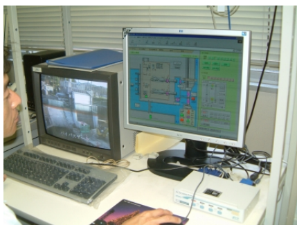
写真 5-2-29 排・取水門の遠隔操作状況
