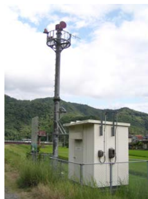
写真 5-2-17 八田原ダム放流警報設備
