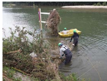
写真 5-2-15 塵芥除去作業状況
