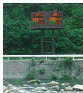
写真 5-2-35 八田原ダム情報掲示板
