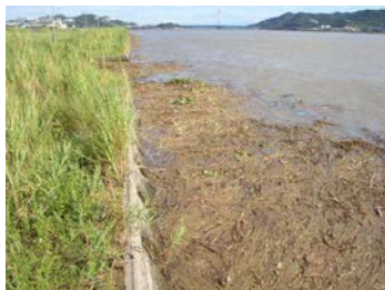
写真 5-2-14 洪水後の塵芥堆積状況
