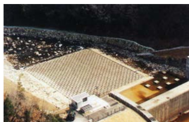
写真 5-1-13 礫間接触酸化施設
