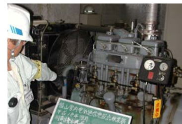
写真 5-2-3 排水機場の点検状況
