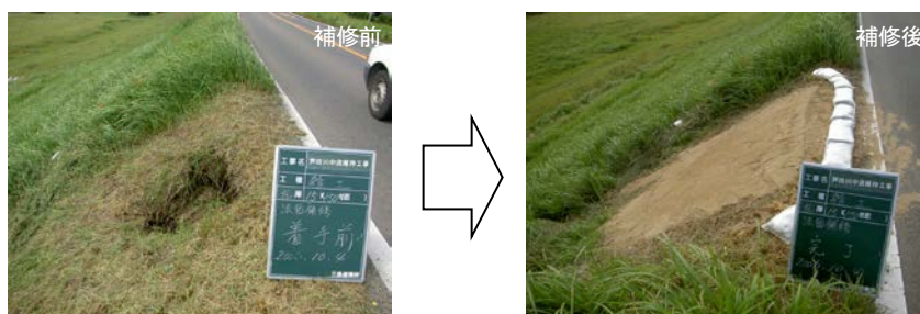
写真 5-2-8 堤防の補修状況
