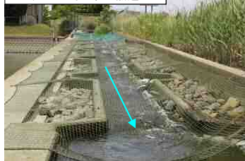
芦田川河口堰の魚道
