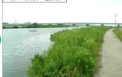
瀬戸川合流部 整備後
