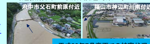
平成30年7月豪雨での被害状況
