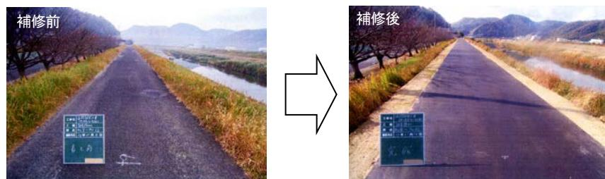
22   写真 5-2-9 堤防天端（上面）の補修状況
