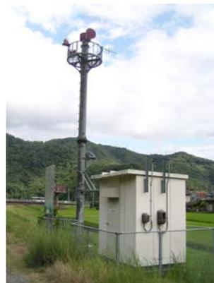
写真 5-2-17 八田原ダム放流警報設備
