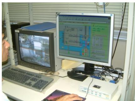
写真 5-2-29 排・取水門の遠隔操作状況
