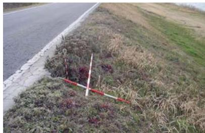
25 写真 2-3-1 堤防の陥没
