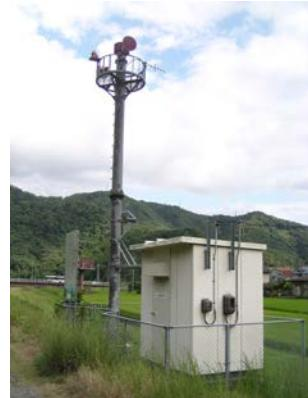
写真 5-2-17 八田原ダム放流警報設備
