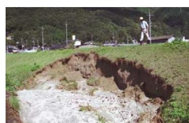
写真 2-3-8 洪水による堤防の損傷
