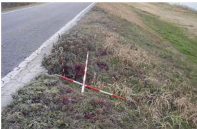
写真 2-3-1 堤防の陥没
