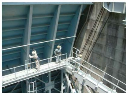
写真 5-2-16 クレストゲートの点検状況
