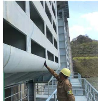
写真 2-3-5 ゲート扉体の点検状況
