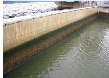
写真 2-3-6 主ゲートの劣化状況
