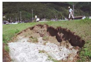
写真 2-3-8 洪水による堤防の損傷
