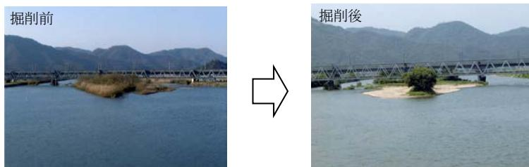
18                   写真5-2-12 堆積土砂の撤去状況(芦田川|9k000付近)
