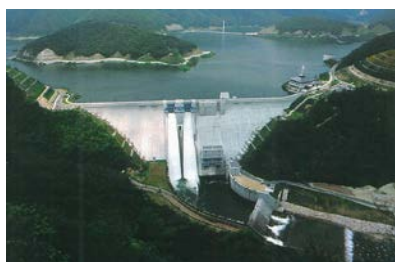
写真 1-2-4 八田原ダム（平成 10 年 3 月完成）
