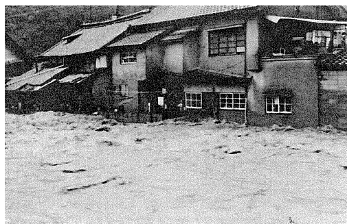
芦品郡新市町の浸水状況
