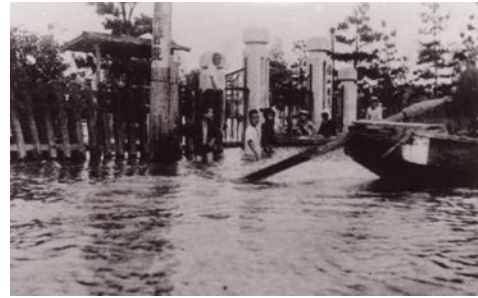
南小学校前の浸水状況
