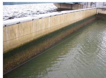
写真 2-3-6 主ゲートの劣化状況
