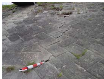
写真 2-3-2 老朽化による護岸のクラック
