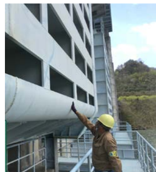
写真 2-3-5 ゲート扉体の点検状況
