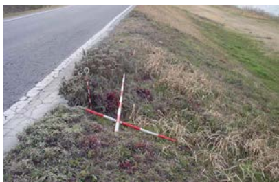
写真 2-3-1 堤防の陥没
