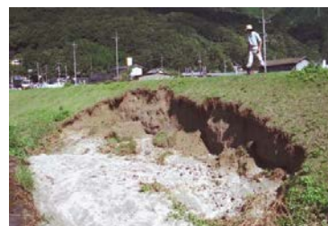
写真 2-3-8 洪水による堤防の損傷
