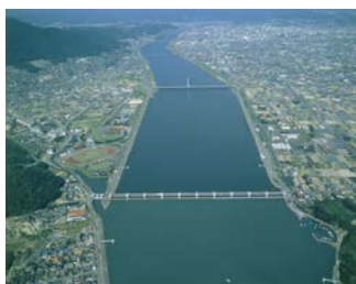
18 写真 2-2-25 芦田川河口堰と湛水区間
