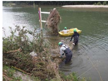
写真 5-2-15 塵芥除去作業状況
