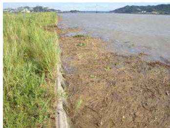
9 写真 5-2-14 洪水後の塵芥堆積状況
