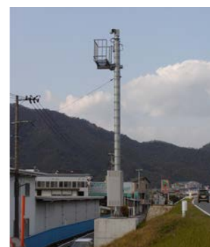
写真 5-2-11 CCTV の設置状況
