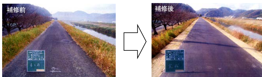
22 写真 5-2-9 堤防天端（上面）の補修状況
