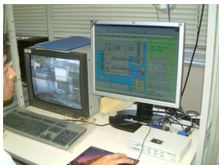
写真 5-2-29 排・取水門の遠隔操作状況
