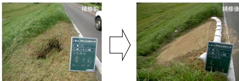
11 写真 5-2-8 堤防の補修状況
