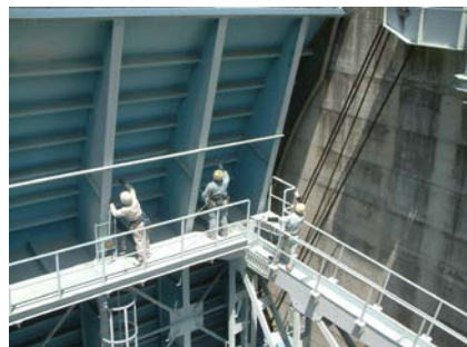
23 写真 5-2-16 クレストゲートの点検状況
