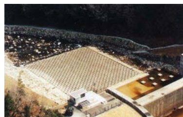
写真 5-1-13 礫間接触酸化施設
