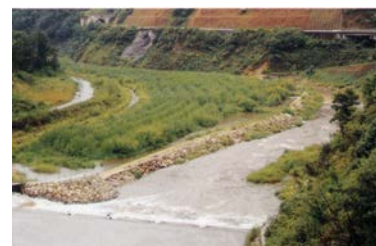
写真 5-1-11 植生浄化施設
