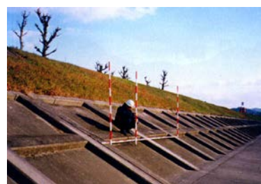
写真 5-2-5 洪水痕跡調査
