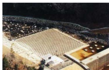
写真 5-1-13 礫間接触酸化施設
