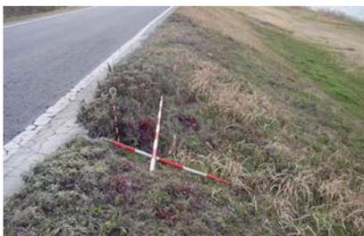
写真 2-3-1 堤防の陥没
